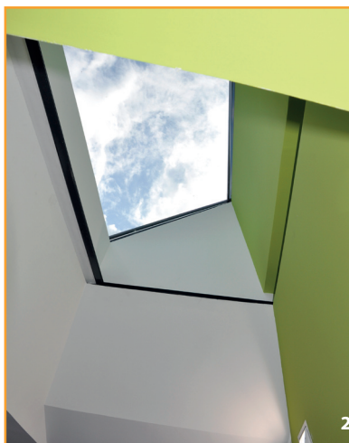
Puits de lumière dans la toiture
