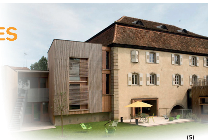
Aménagement d'un logement de gardien
