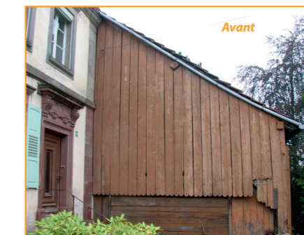
Avant Aménagement d'un logement : reprise du bardage du schopf pour amener de la lumière
