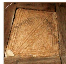
Ceci n'est pas un décor, les traces sont réalisées pour créer un accrochage pour l'enduit de finition.
