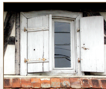
Volets pleins traditionnels : simples planches de bois
